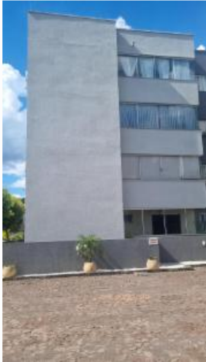
Fachada sul bloco1 - varanda apto 101
