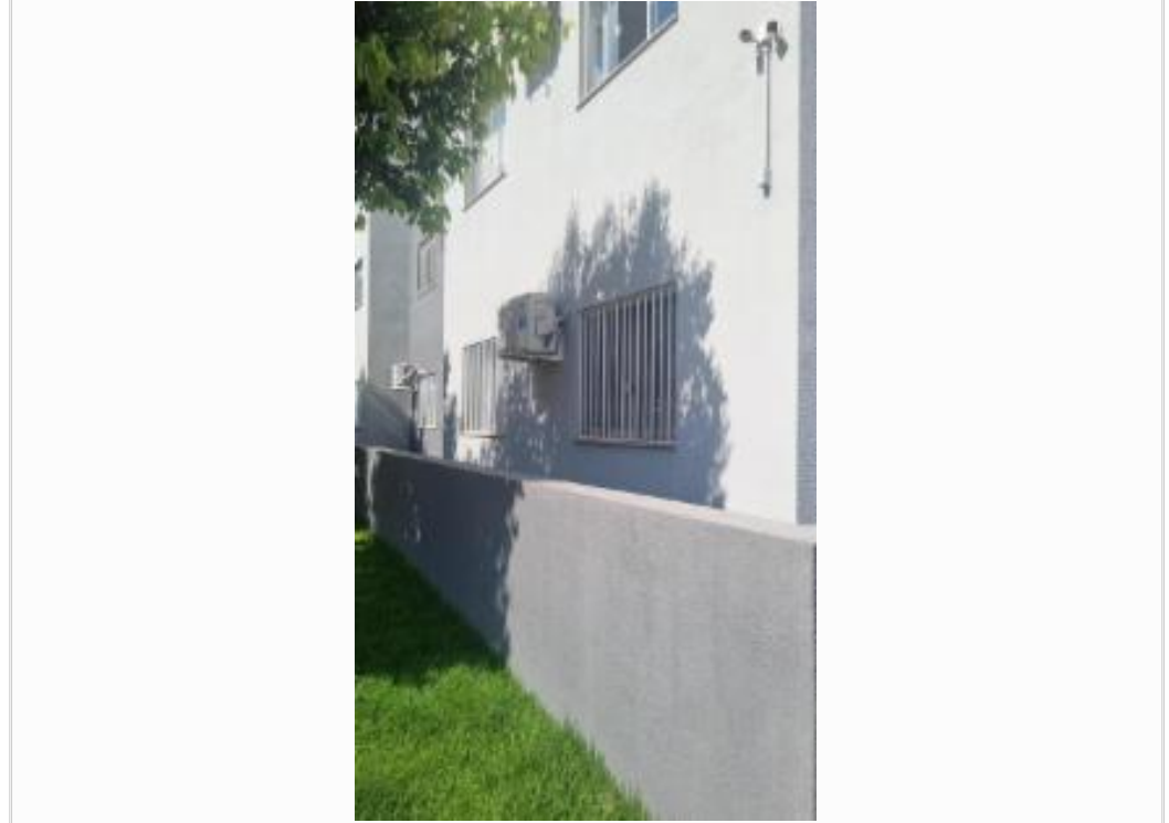
Dormitorios apto 101 - fachada oeste
