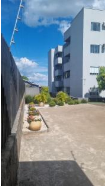
Fachada norte bloco 1
