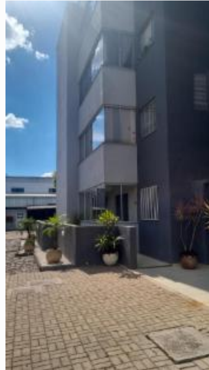
Fachada sul - apto 101 terreo
