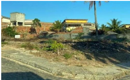
Representação Fachada Principal Descrição AMOSTRA 5 Data Foto 16/09/2024
