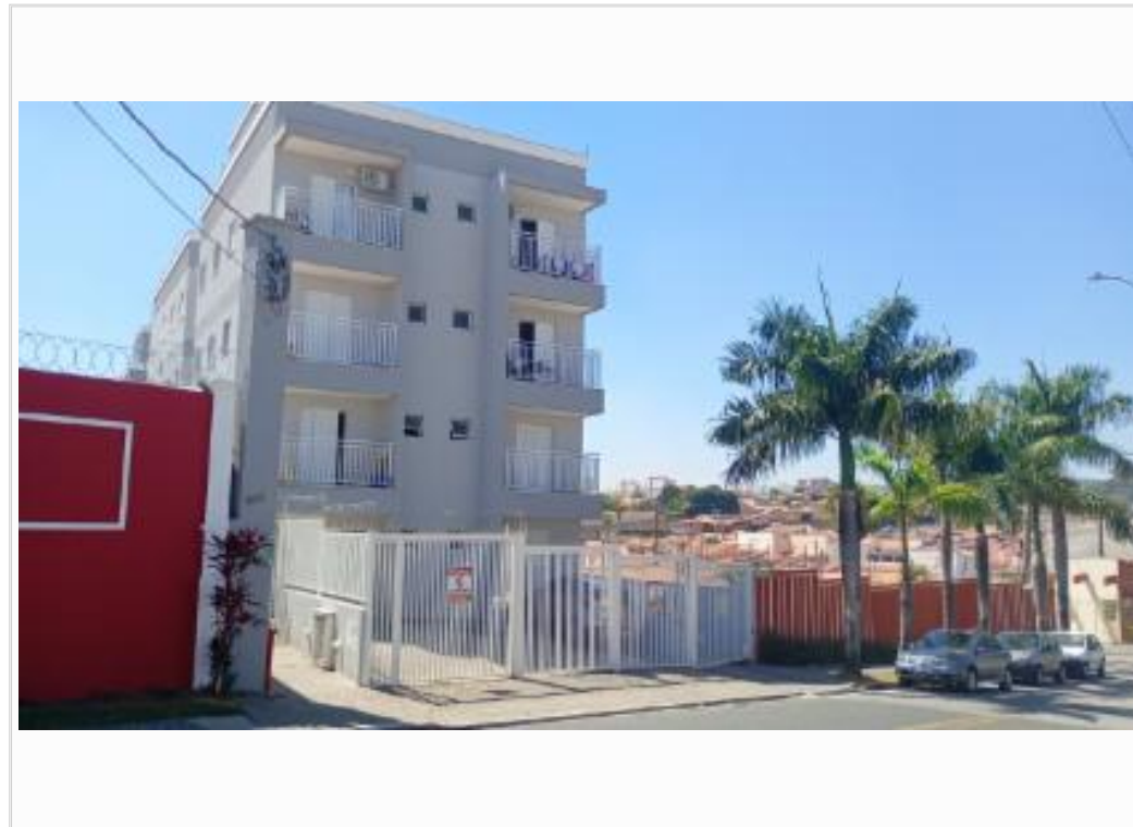
vista da fachada do edifício
