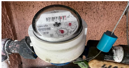
Representação Fachada Principal Descrição Relógio de água Data Foto 23/11/2022
