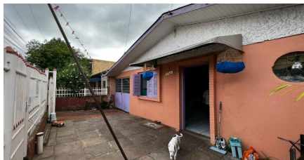
Representação Fachada Principal Descrição Data Foto 23/11/2022
