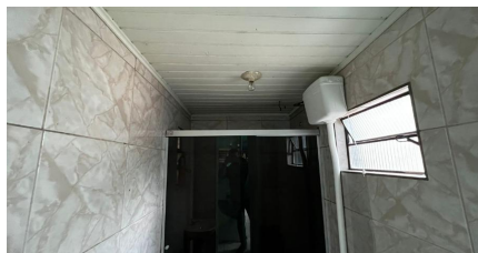
Representação Banheiro Descrição Banheiro 2, localizado no imóvel do fundo Data Foto 23/11/2022
