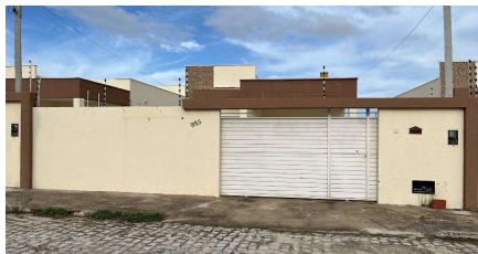
Representação Fachada Principal Descrição Data Foto 01/03/2024
