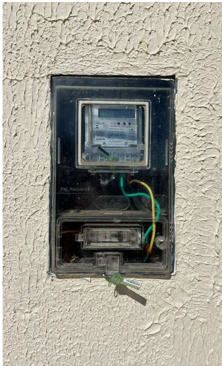
Representação Fachada Principal Descrição Medidor Energia Data Foto 05/04/2024
