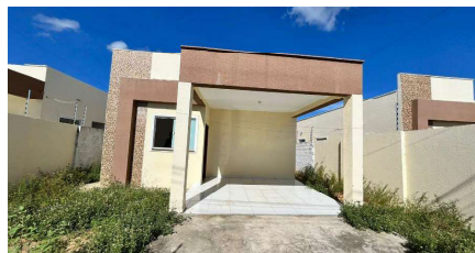
Representação Garagem Descrição Entrada / Garagem Data Foto 05/04/2024
