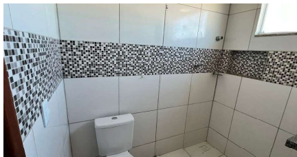
Representação Banheiro social Descrição Banheiro Social Data Foto 05/04/2024
