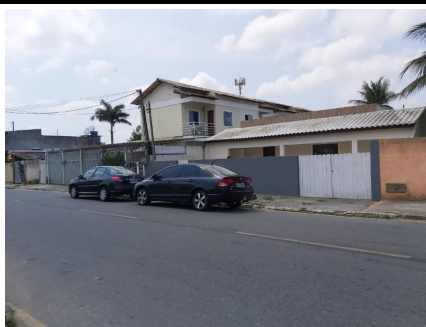
Representação Fachada Principal Descrição Data Foto 29/09/2020
