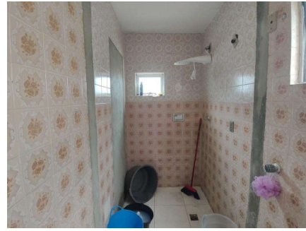
Representação Banheiro social Descrição Data Foto 08/12/2021
