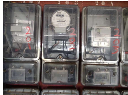
Representação Descrição Medidores Data Foto 08/12/2021
