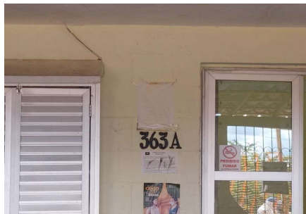
Representação Fachada Principal Descrição Data Foto
