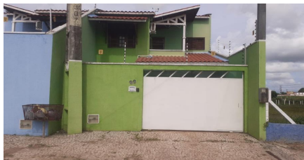
Representação Fachada Principal Descrição Data Foto 04/03/2024
