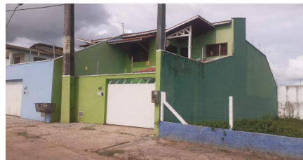
Representação Fachada Principal Descrição Data Foto 04/03/2024
