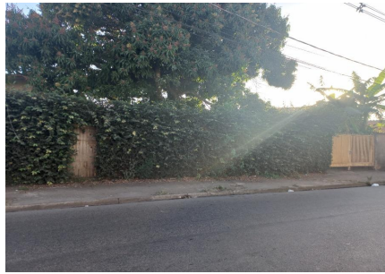
Representação Fachada Principal Descrição Data Foto 09/08/2023
