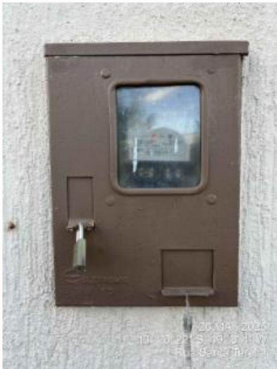
Medidor energia
