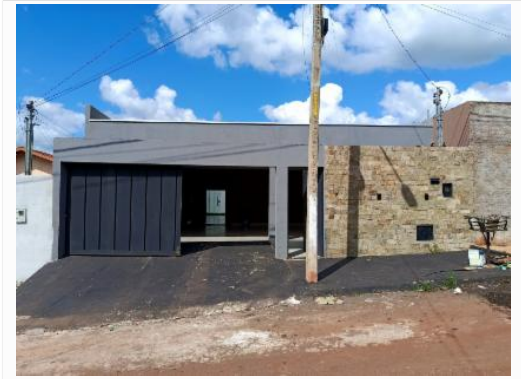
Fachada do avaliando
