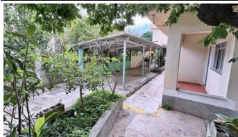
Representação Fachada Principal Descrição Data Foto 02/07/2026
