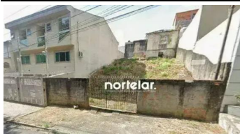
Representação Fachada Principal Descrição Data Foto 02/07/2026
