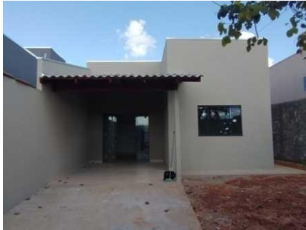
Representação Fachada Principal Descrição Data Foto 17/02/2022
