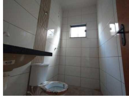
Representação Banheiro Suíte Descrição Data Foto 17/02/2022
