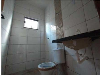
Representação Banheiro social Descrição Data Foto 17/02/2022
