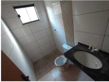
Representação Banheiro social Descrição Data Foto 17/02/2022
