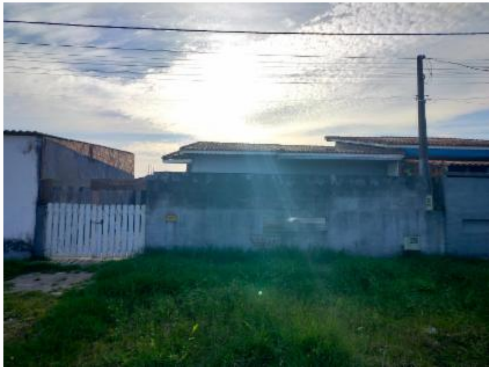
Fachada do avaliando
