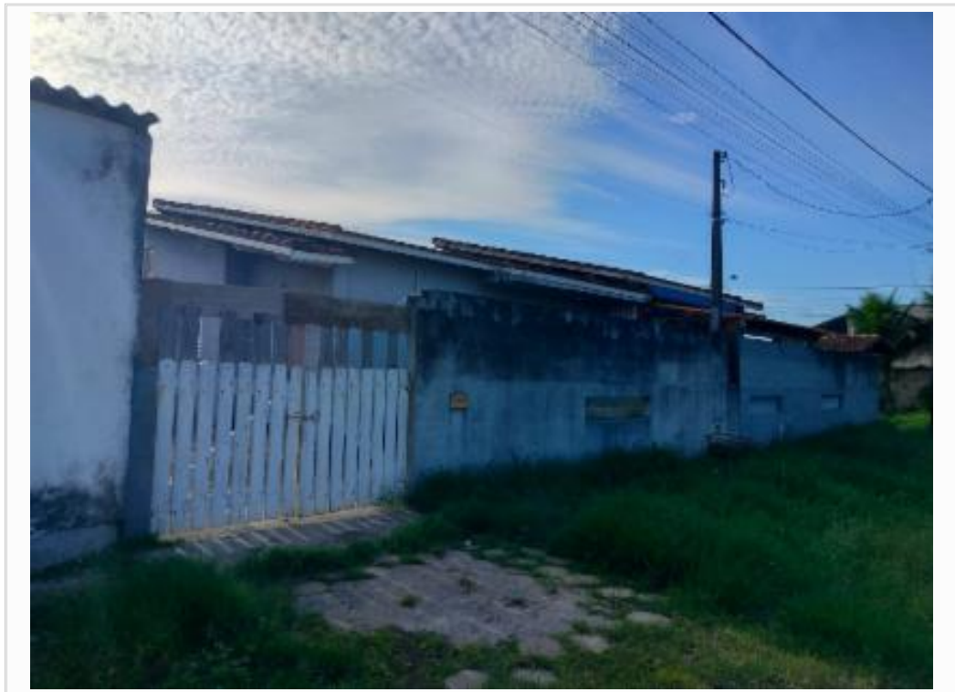
Fachada do avaliando
