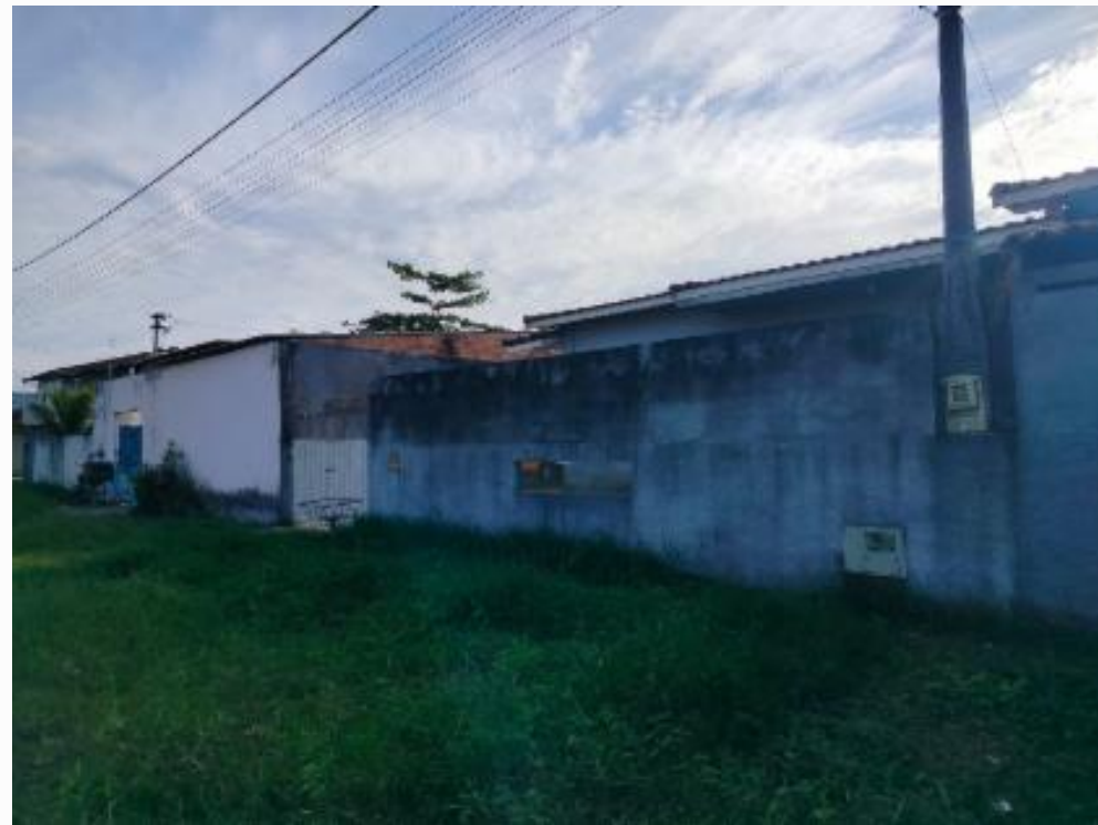
Fachada do avaliando
