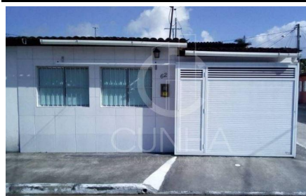
Representação Fachada Principal Descrição Data Foto 17/05/2023
