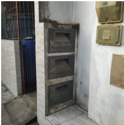
Representação Descrição Medidores Data Foto 10/05/2022
