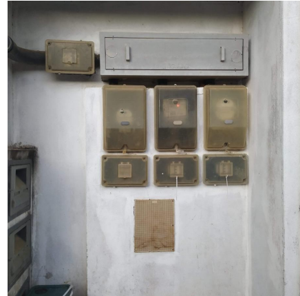
Representação Descrição Medidores Data Foto 10/05/2022
