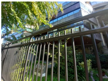
Representação Fachada Principal Descrição Data Foto 20/06/2022
