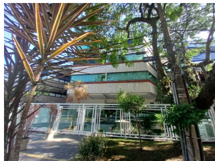
Representação Vista da Rua Descrição VIZINHO ESQUERDO Data Foto 20/06/2022
