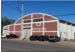
Representação Fachada Principal Descrição Data Foto 03/08/2023
