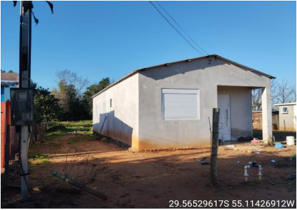
Representação Fachada Principal Descrição Data Foto 03/08/2023
