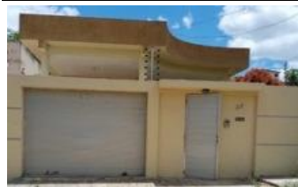
Representação Fachada Principal Descrição Data Foto 07/11/2022
