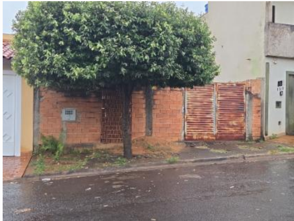
Fachada do vizinho esquerdo
