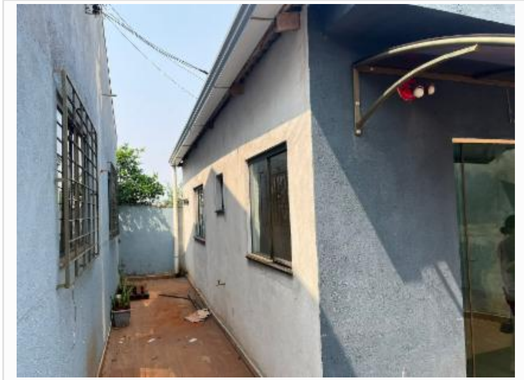
Lateral do imóvel
