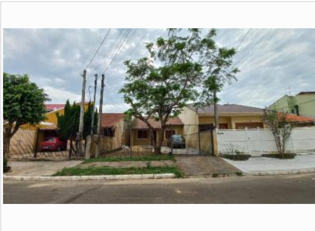
Fachada do avaliando
