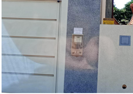
Representação Fachada Principal Descrição Data Foto 20/11/2023
