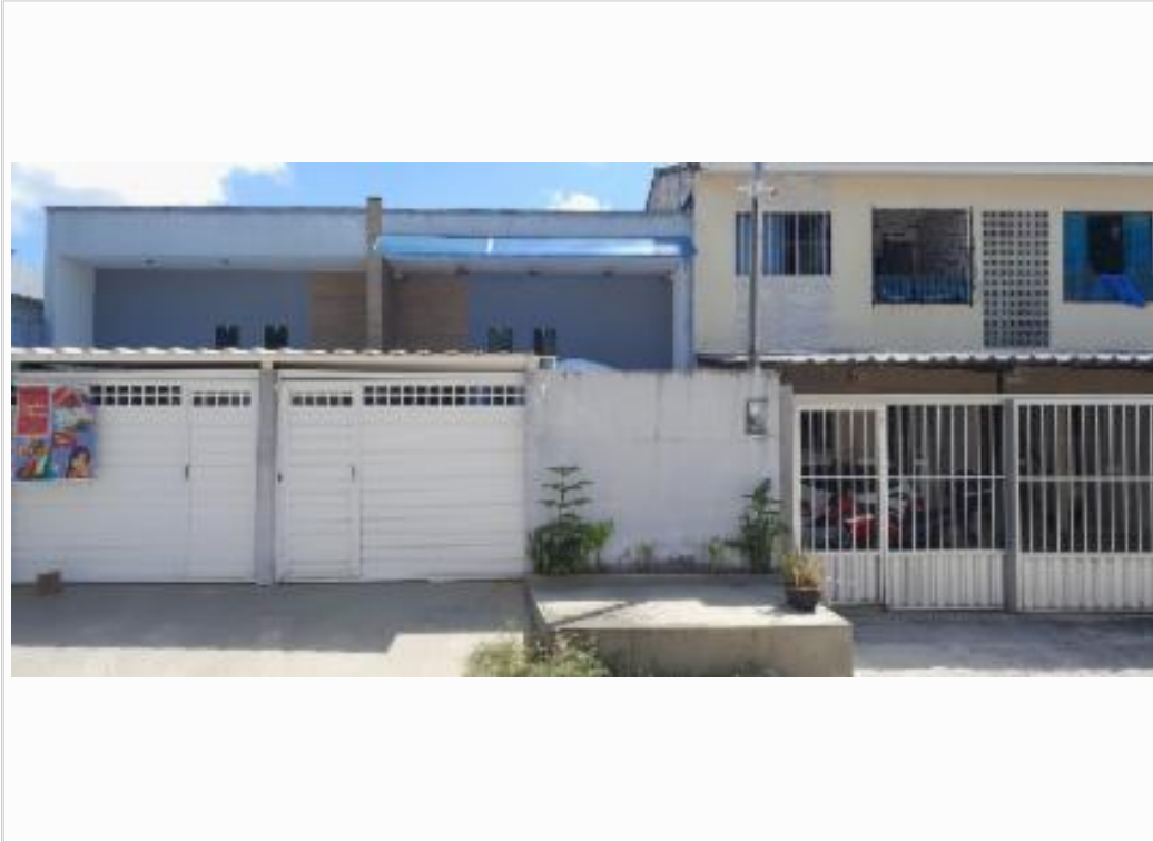
Fachada do avaliando
