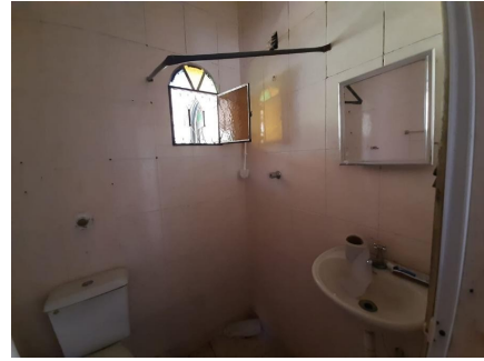
Representação Banheiro social Descrição Data Foto 11/04/2022
