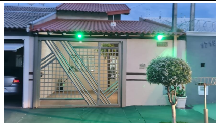
Representação Fachada Principal Descrição FACHADA IMÓVEL
