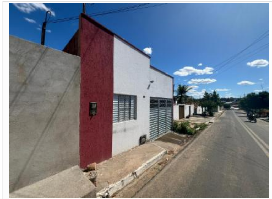
Fachada do avaliando, vista 02
