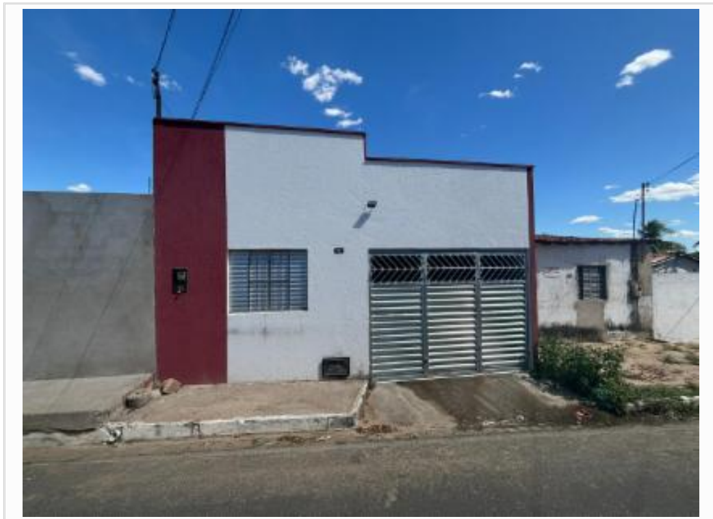
Fachada do avaliando, vista 01
