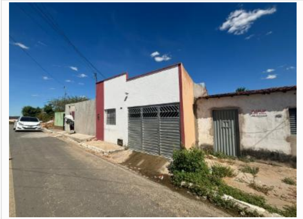
Fachada do avaliando, vista 03
