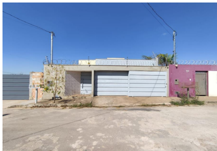
Representação Fachada Principal Descrição Data Foto 06/07/2023
