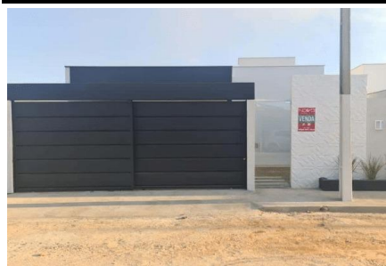
Representação Fachada Principal Descrição Data Foto 06/07/2023
