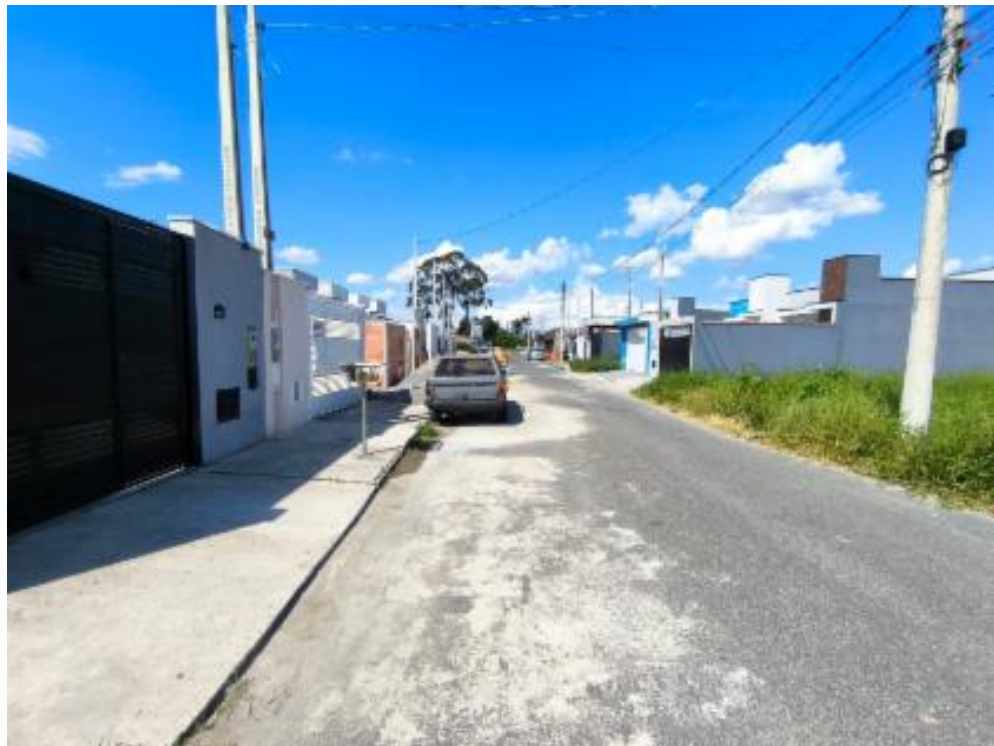
Vista da rua
