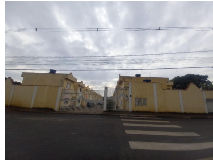
Representação Fachada Principal Descrição Data Foto 10/06/2022
