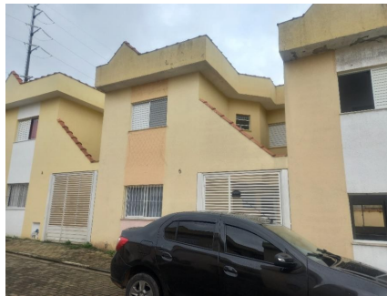
Representação Vista da Rua Descrição VIZINHO LADO ESQUERDO Data Foto 10/06/2022
