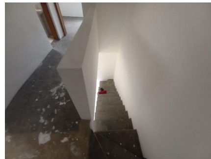
Representação Corredor Descrição ESCADA DE ACESSO AO 2 PAVIMENTO Data Foto 10/06/2022
