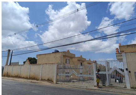
Representação Fachada Principal Descrição Fachada do imóvel Data Foto 20/12/2023
