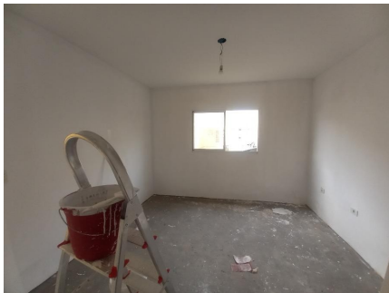
Representação Sala de Estar / Visitas Descrição Data Foto 10/06/2022
