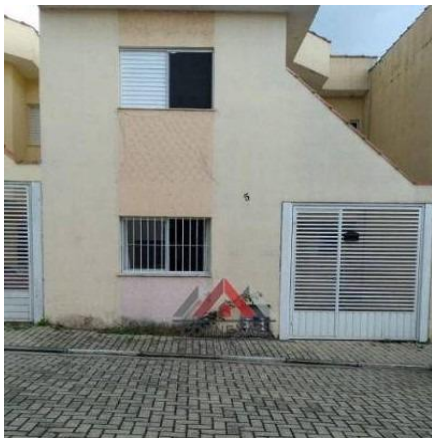
Representação Fachada Principal Descrição AMOSTRA 3 Data Foto 22/12/2023
