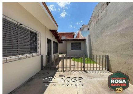
Representação Fachada Principal Descrição Data Foto
