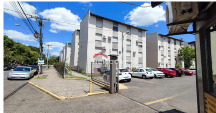
Representação Fachada Principal Descrição Data Foto
