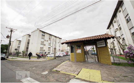
Representação Fachada Principal Descrição Data Foto
