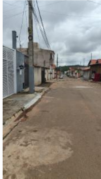
Vista da rua
