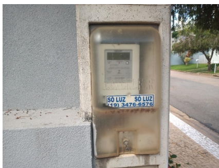
Representação Fachada Principal Descrição Relógio Data Foto 21/01/2022
