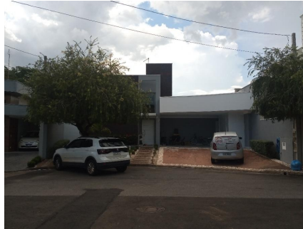
Representação Fachada Principal Descrição Fachada do imóvel avaliado Data Foto 21/01/2022
