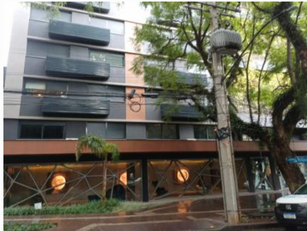
Fachada avaliando condomínio
