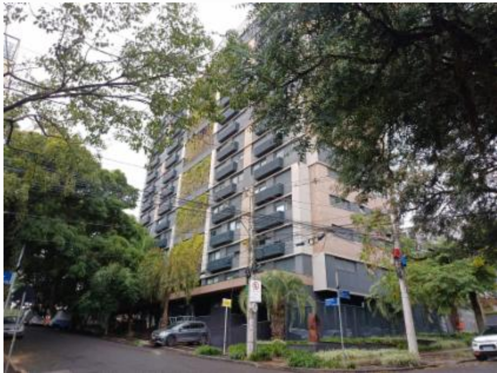
Fachadas do avalaindo condomínio
