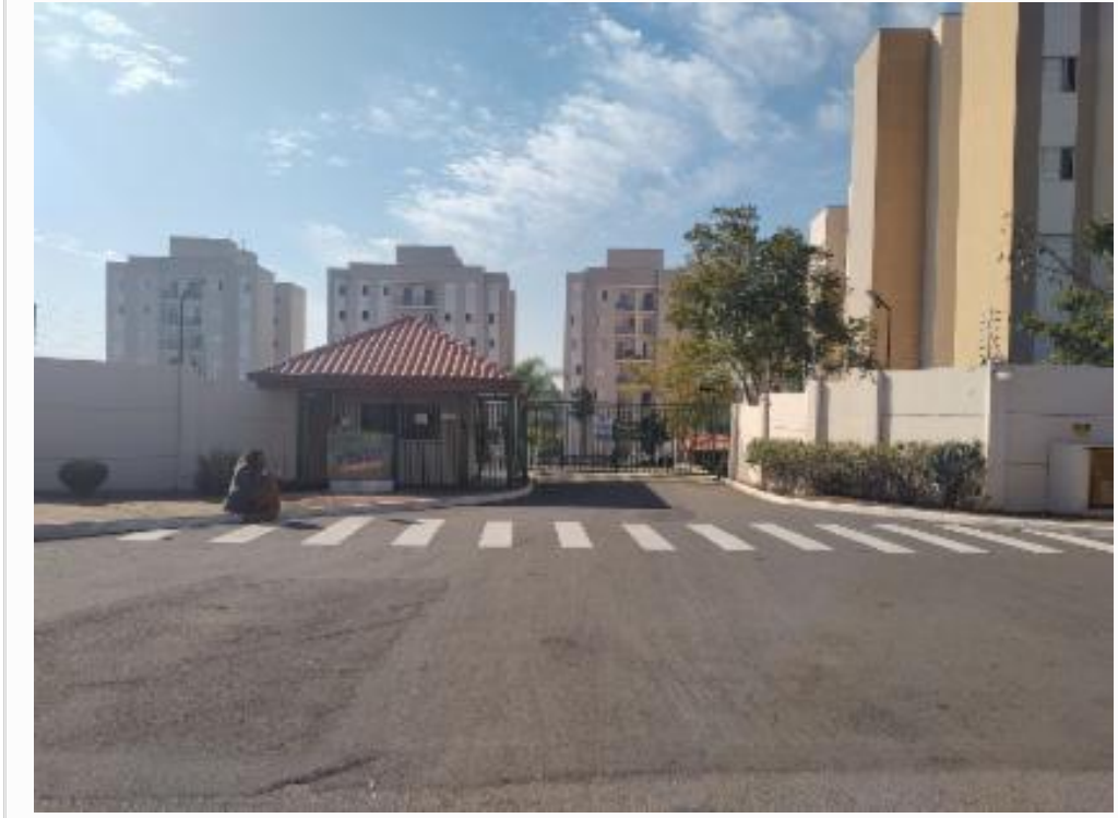
Portaria do condomínio
