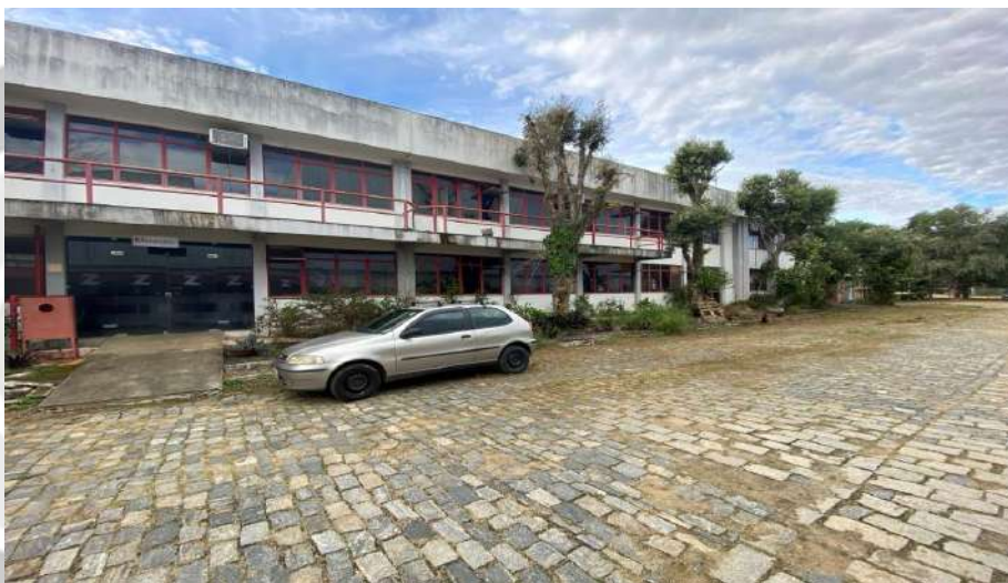
Fachada prédio da administração
