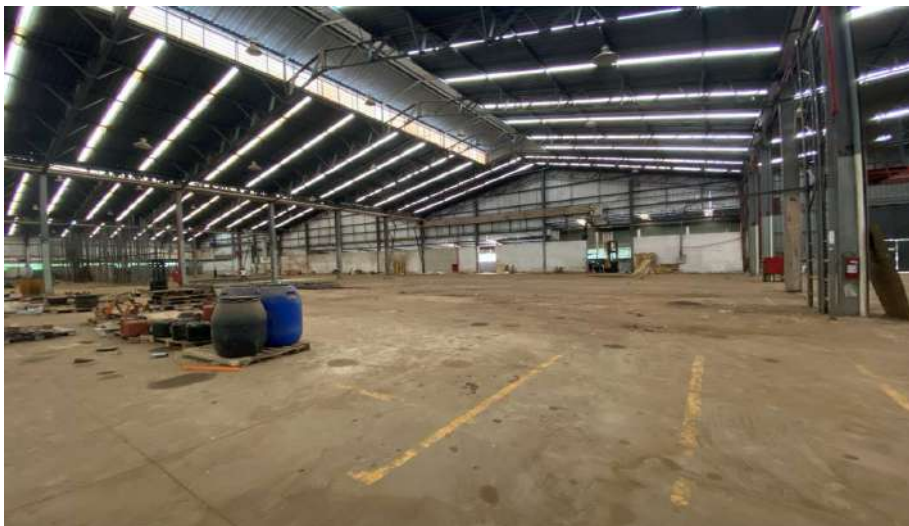
Vista interna galpão
