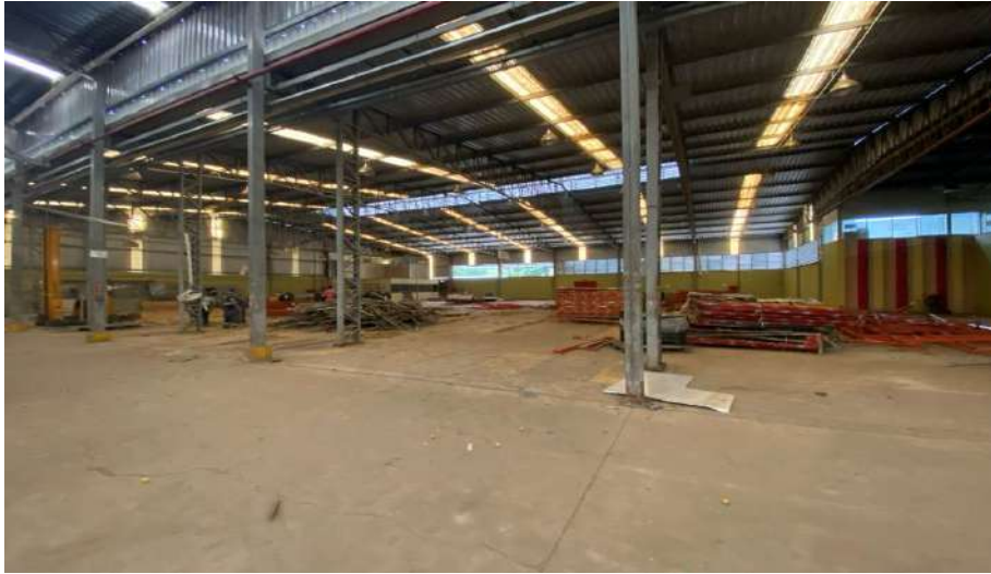
Vista interna galpão
