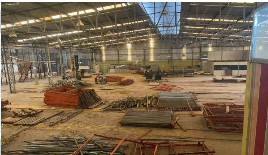
Vista interna galpão
