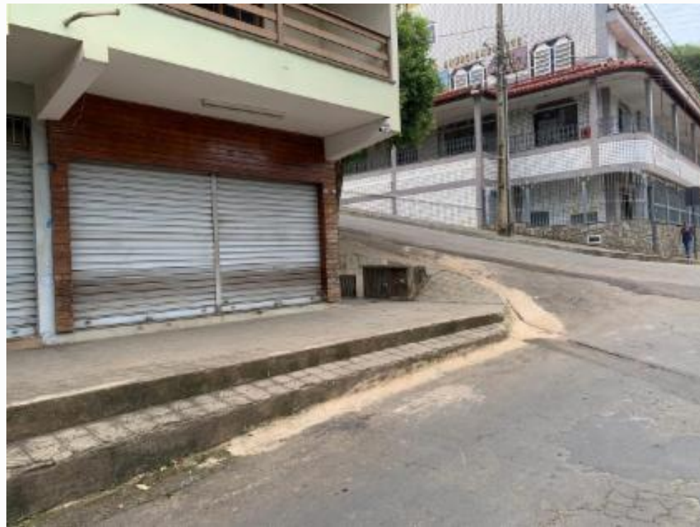
vista parcial da fachada do edifício
