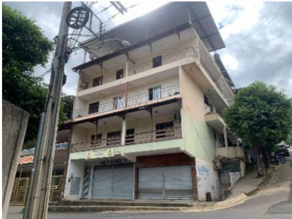
vista parcial da fachada do edifício
