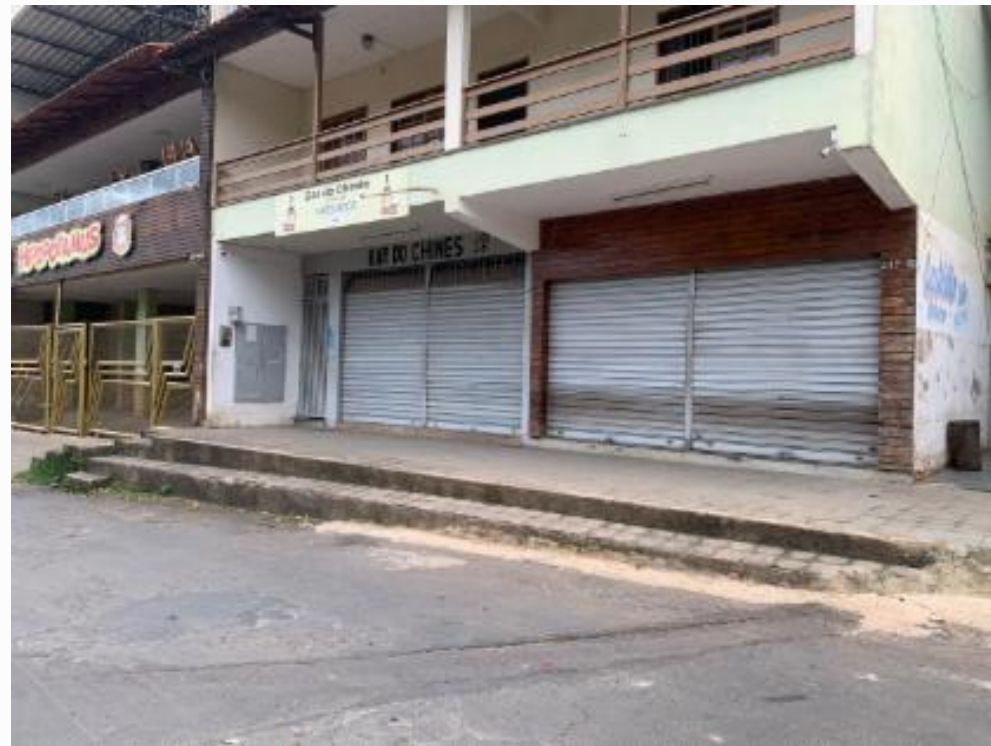
vista parcial da fachada do edifício
