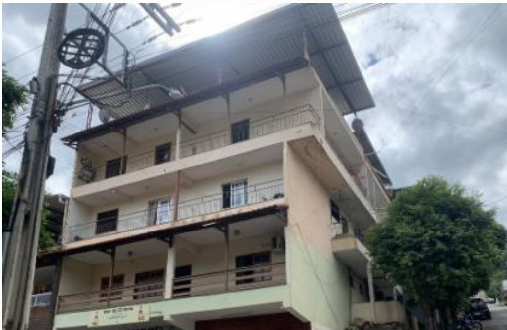
vista parcial da fachada do edifício
