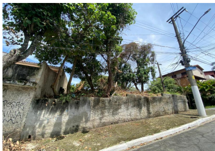
Representação Vista da Rua Descrição Vizinho Direita +1 Data Foto 15/03/2023
