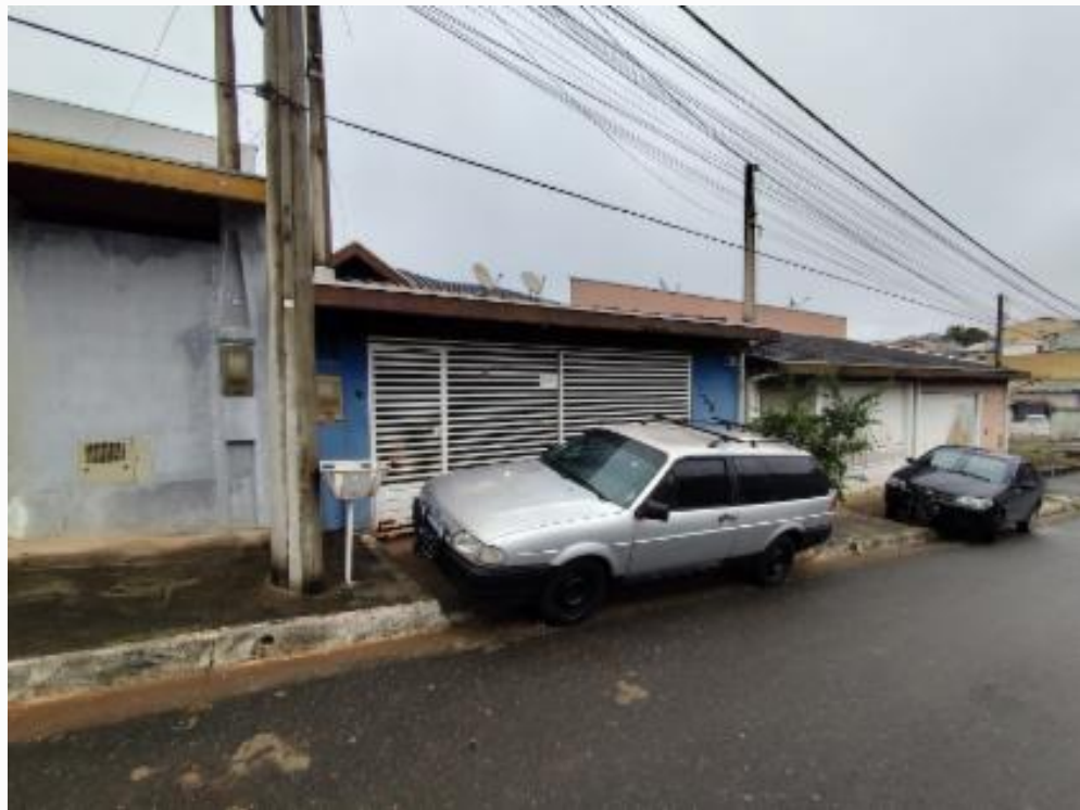
Fachada do imóvel avaliando
