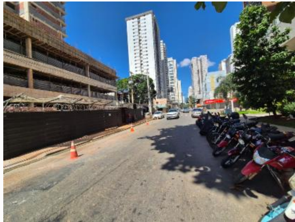
02. LOGRADOURO ESQUERDO RUA T-30
