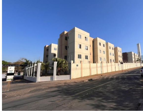
Vista parcial do condomínio
