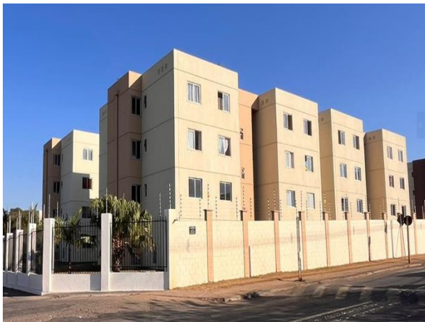
Vista parcial do condomínio
