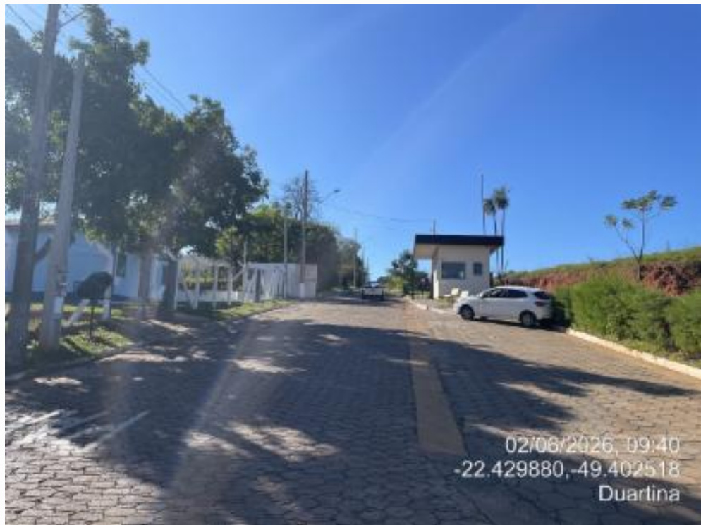
Fachada condomniio ampla
