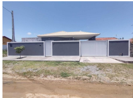
Representação Fachada Principal Descrição Fachada Externa Data Foto 02/12/2021
