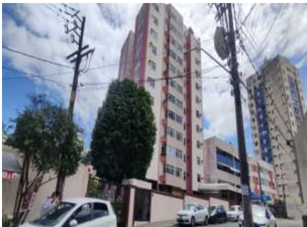
Vista parcial do edifício
