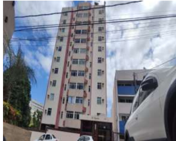
Vista parcial do edifício
