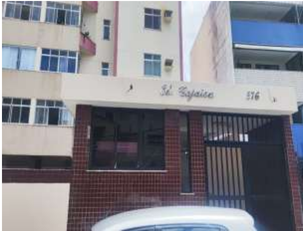
Vista parcial do edifício
