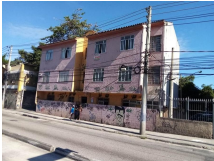
Representação Vista da Rua Descrição Vizinho - Direita Data Foto 28/04/2020
