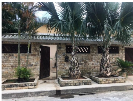
Representação Fachada Principal Descrição Avaliando, vista 03 Data Foto 28/10/2020
