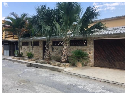
Representação Fachada Principal Descrição Avaliando, vista 02 Data Foto 28/10/2020
