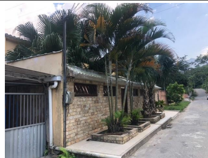
Representação Fachada Principal Descrição Avaliando, vista 01 Data Foto 28/10/2020
