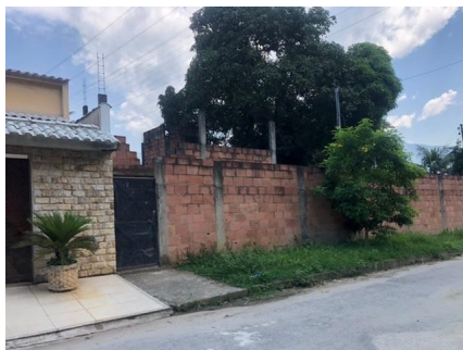
Representação Fachada Principal Descrição Vizinho à direita Data Foto 28/10/2020
