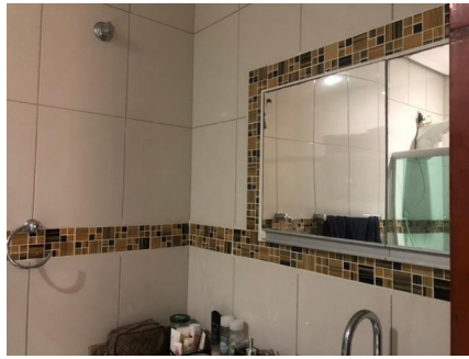
Representação Banheiro Suíte Descrição Suíte 01, vista 04 Data Foto 28/10/2020
