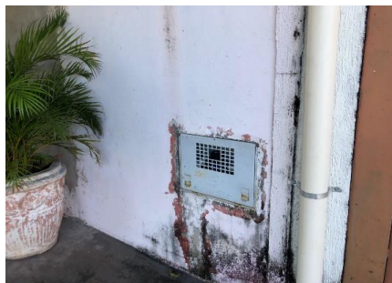
Representação Fachada Principal Descrição Data Foto
