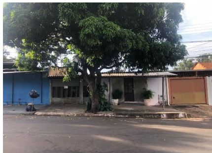
Representação Fachada Principal Descrição Data Foto
