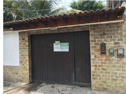
Representação Fachada Principal Descrição Condomínio Data Foto 04/10/2021
