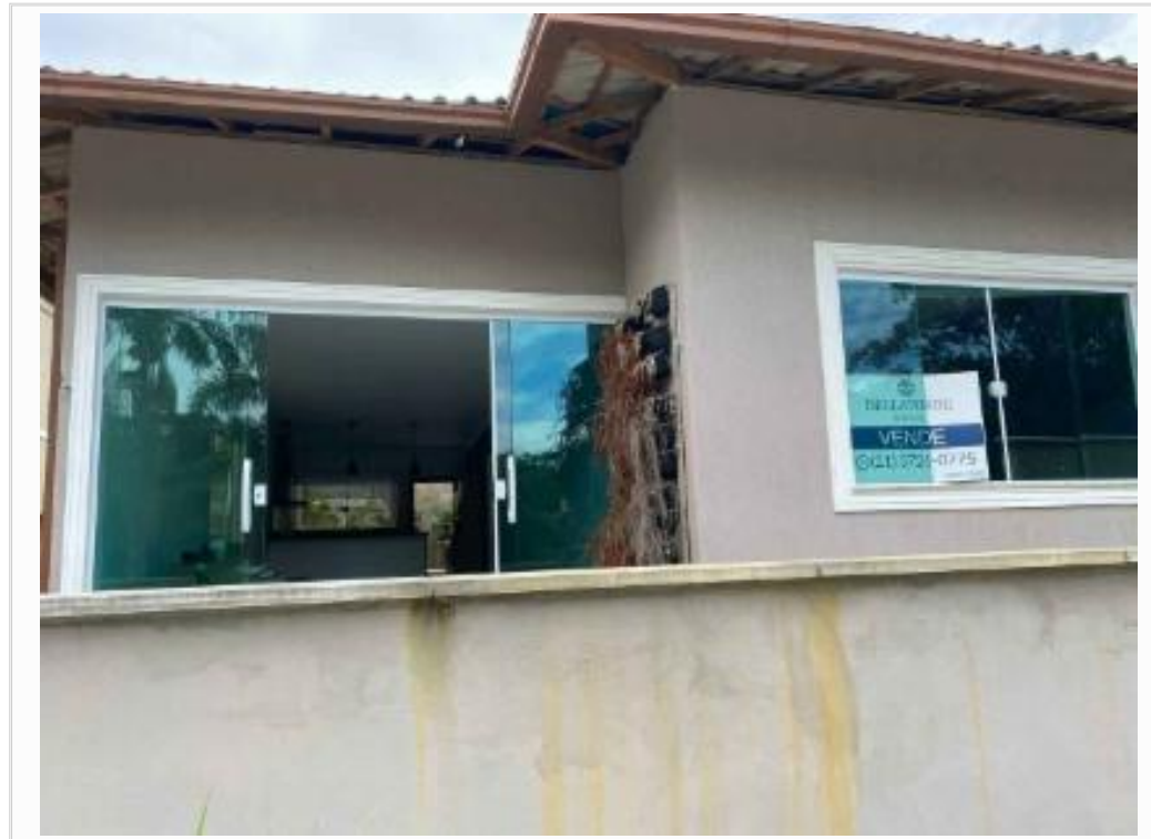
VISTA APROXIMADA DA FACHADA
