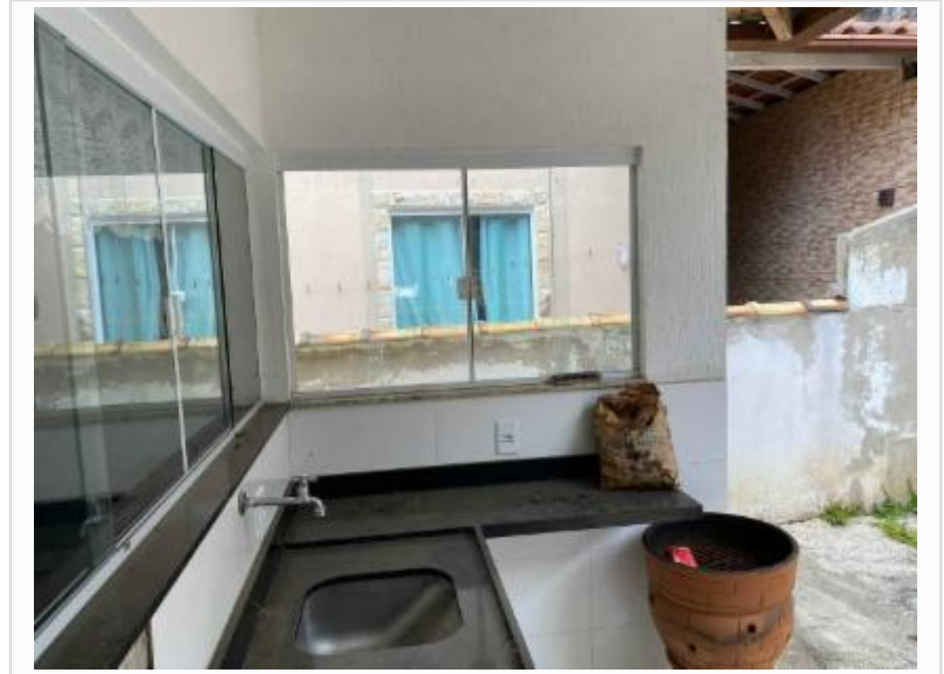
VISTA APROXIMADA DA ÁREA DE SERVIÇO
